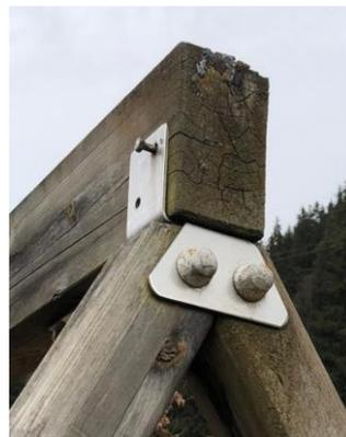
Außerdem ist der obere Balken mit **langen Längsrissen** durchzogen:
