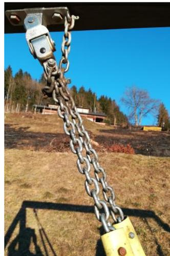
Beim **oberen Balken** ist auf der rechten „talwärtigen“ Seite **nur eine Schraube** angebracht und diese **steht hervor**:
